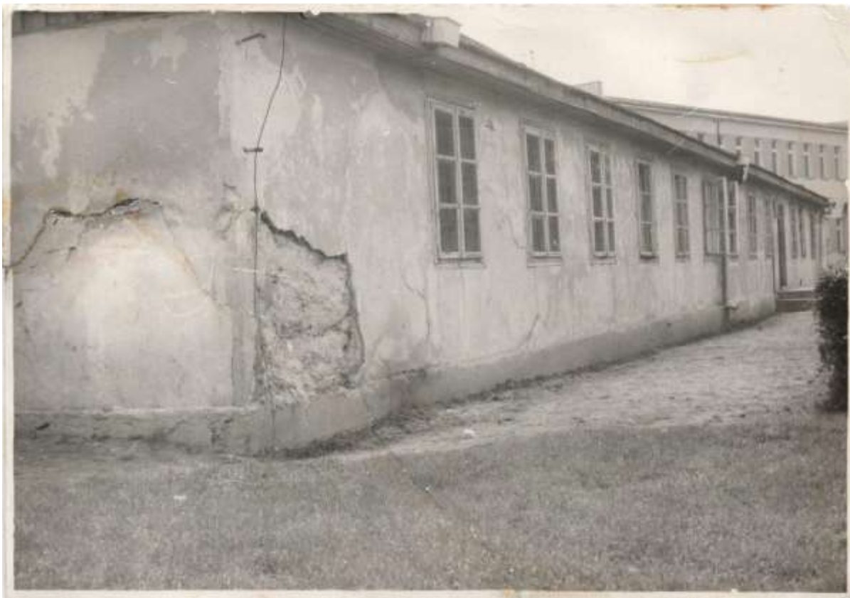
Stary budynek Zasadniczej Szkoły Mechanizacji Rolnictwa
