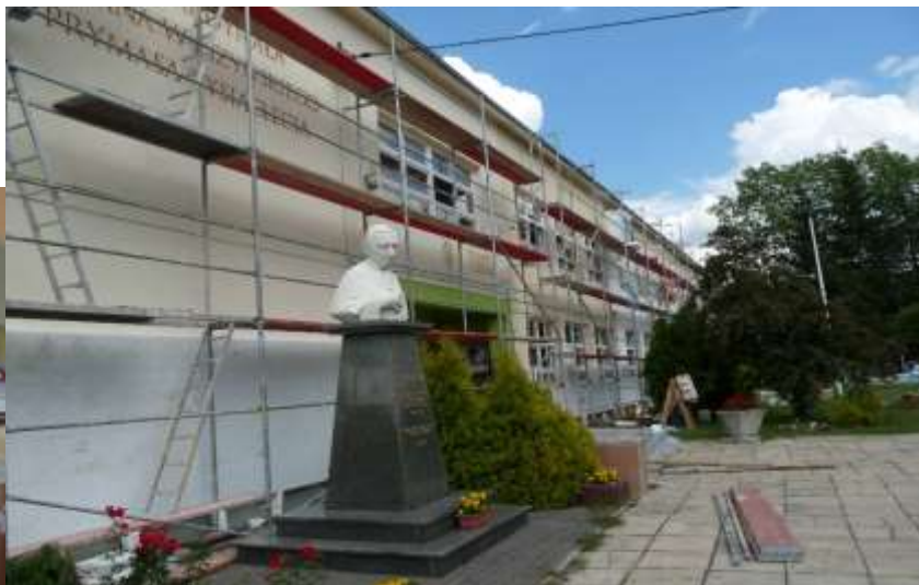
Prace remontowe – termoizolacja budynku
