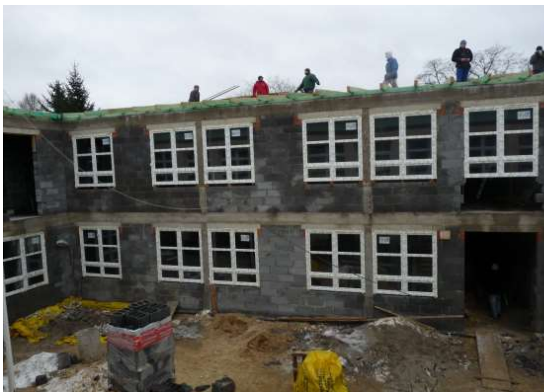
Luty 2013 r. Powstaje nowy budynek szkoły
