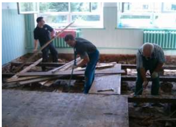
Rodzice uczniów przy pracach remontowych
