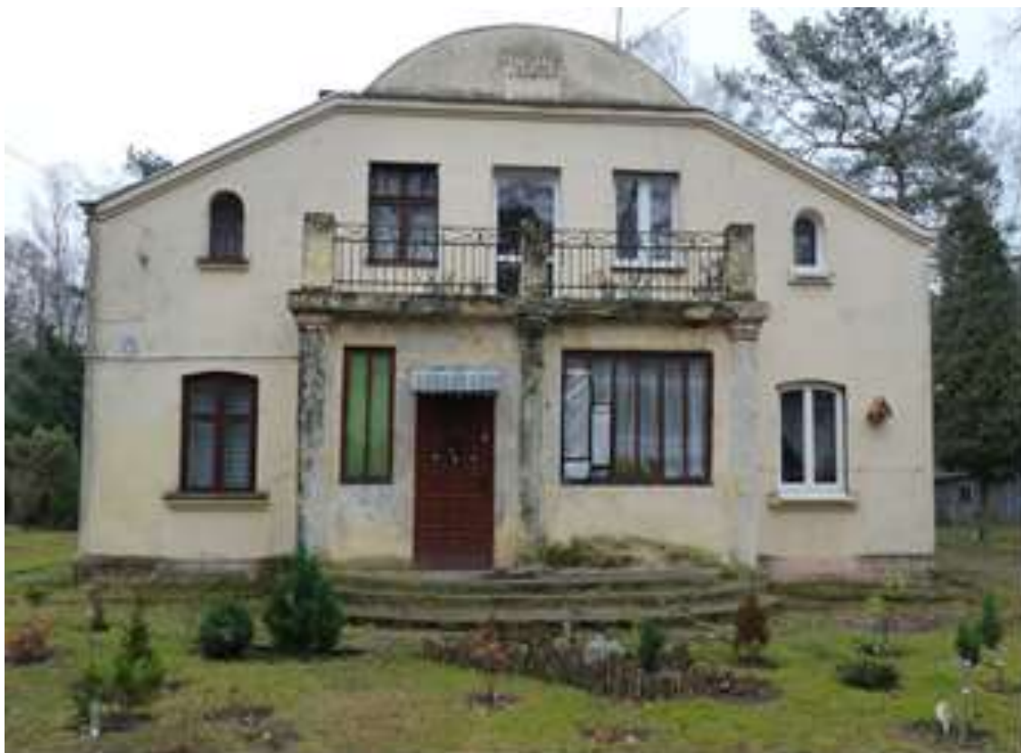
Rąbień, ul. Zagajnikowa 52- willa z 1929 r. Otynkowany ceglany budynek.
