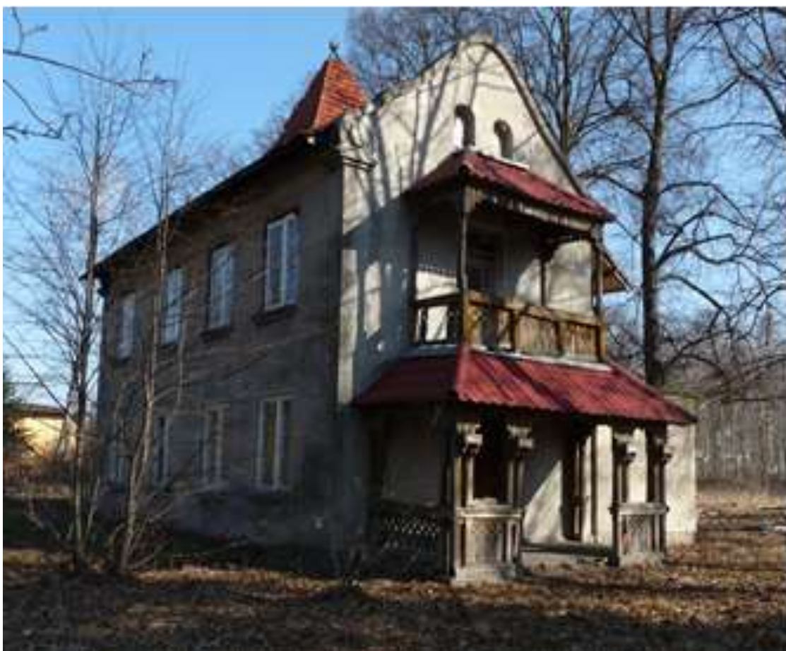
Rąbień, róg ul. Różanej i Wycieczkowej- willa z XIX/XX wieku. Otynkowany ceglany budynek.
